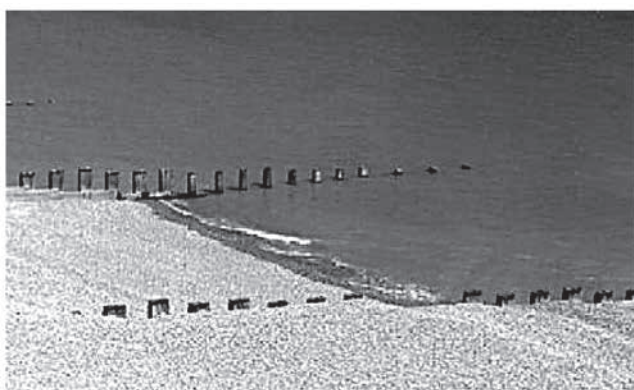
شکل ۳. سازه‌های بتنی برای جلوگیری از فرسایش ساحل [۳]
