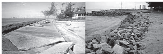
شکل ۲. تخته سنگ (سمت راست) و قطعات بتونی (سمت چپ) برای محافظت از فرسایش [۳]
